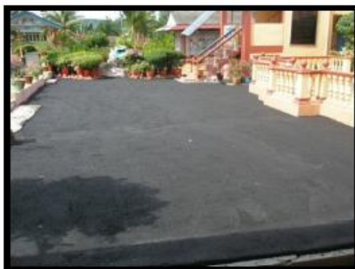
KERJA-KERJA PREMIX DI DATARAN KEJAT SEDIADA
