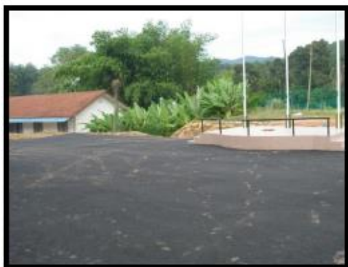
KERJA-KERJA PREMIX DI DATARAN KEJAT BARU
