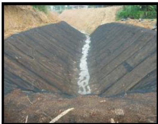
Kerja Pemasangan Enkamat
